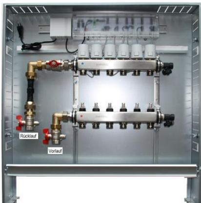
Senkrechte Anschlüsse inkl. Wärmemengen-zähler-Passstück, wahlweise rechts oder links montiert
