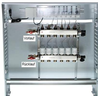
Heizkreisverteiler mit Anschluss waagrecht
